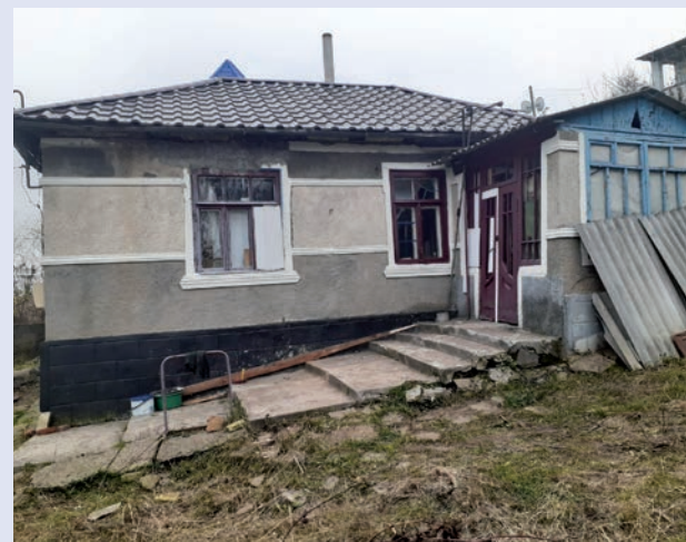
Das Haus von Herrn P., als dieser im Jahr 2019 zurückkehrte. Die Fenster mussten zum Teil von innen und außen notdürftig verklebt werden.
